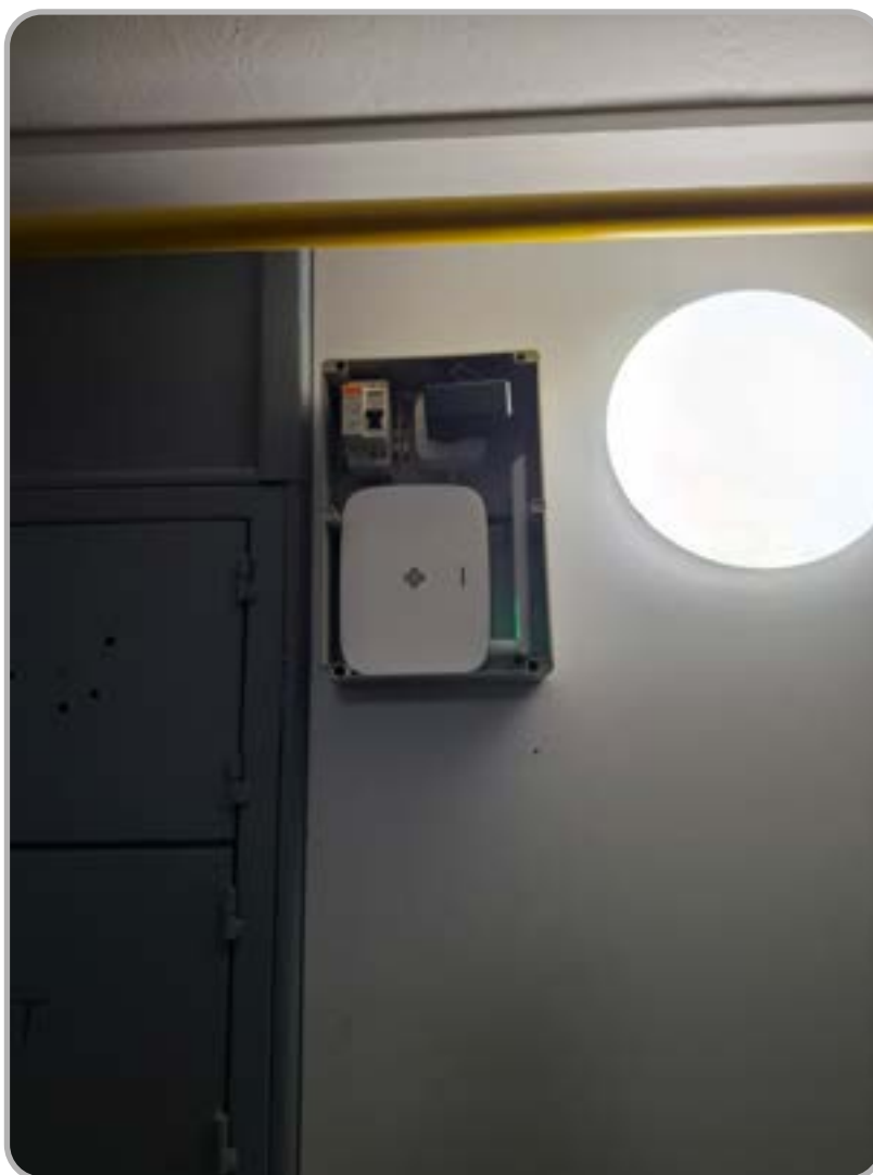
Przykład prawidłowego montażu bramki RAK7268
