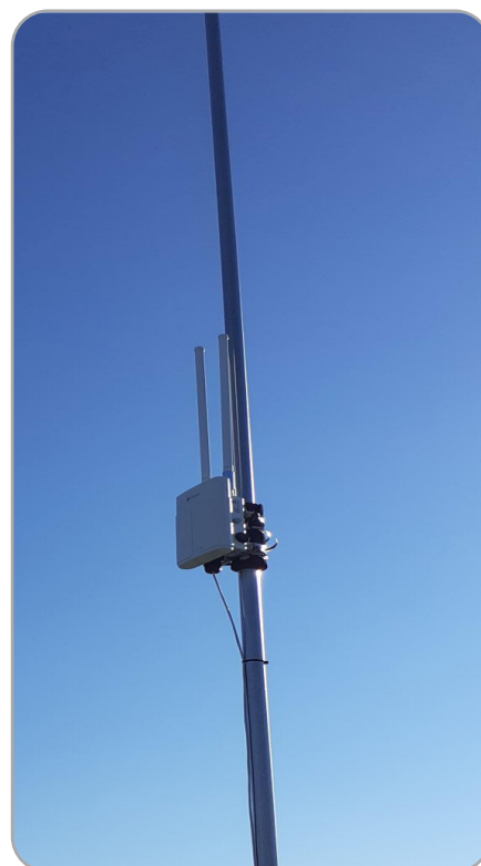
Przykłady prawidłowego montażu bramki RAK7289
