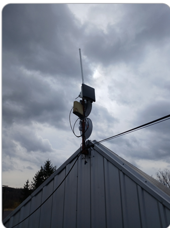
Przykłady prawidłowego montażu bramki RAK7289
